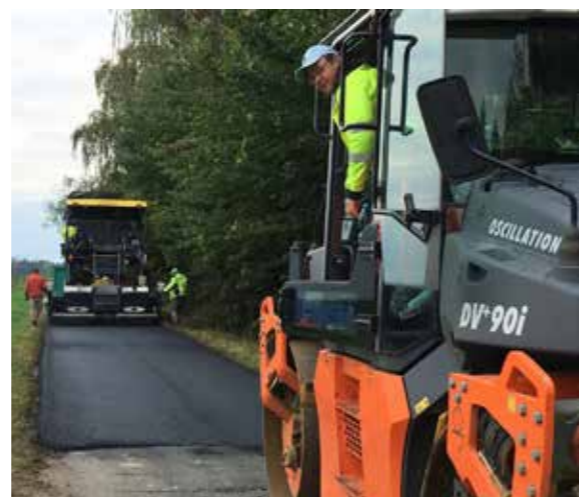
Oprava komunikace Jelmo-Lišov
