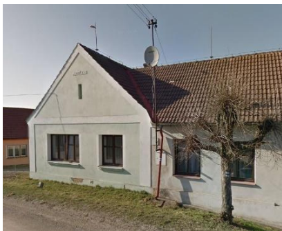
Obr. 1: Příklady řešení styku dvou střech propsáním štítu na fasádě nebo nárožím na domě v Jelmě.
