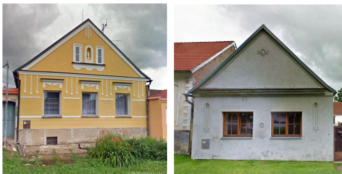
Obr. 4: Příklad okapní římsy na domě v Jelmě - přehled minimální, římsa omítaná, profilace
