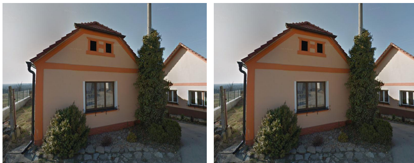
Obr. 3: Příklad přehledů střechy u štítové stěny na domech v Libníči - přehledy minimální
