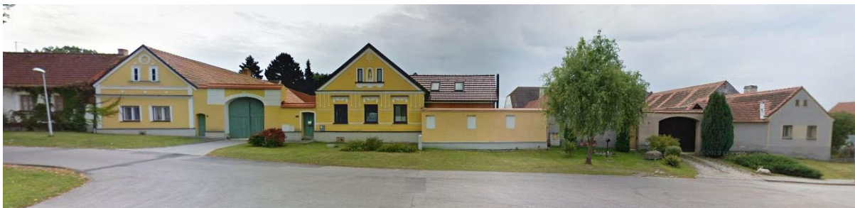
Obr. 8: Dvory na návsi v Libníči často uzavřeny směrem do ulice vysokou omítanou stěnou se zděnou bránou a brankou
