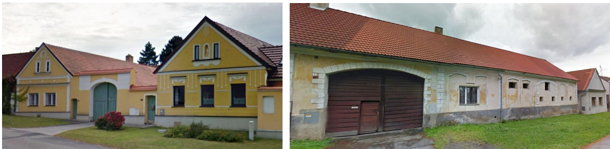
Obr. 7: Příklad štítové i okapové orientace na návsi v Libníči, ve štítech pouze okna
