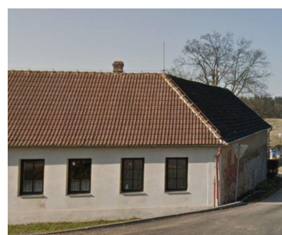
Obr. 1: Příklady řešení styku dvou střech propsáním štítu na fasádě nebo nárožím na domě v Jelmě.
